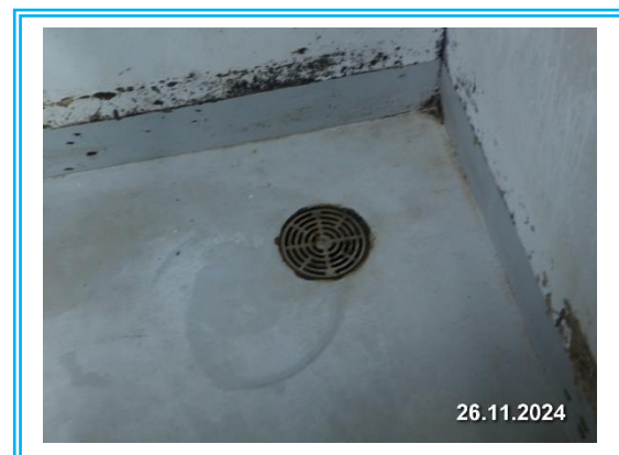
รูปที่ 3-32 ท่อรวบรวมน้ำจากการล้างพื้นห้องพักขยะ
