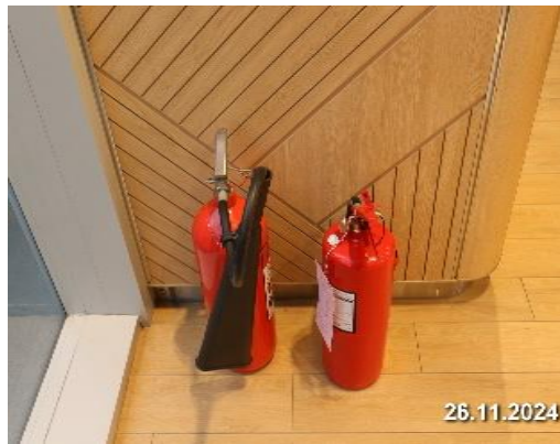
รูปที่ 3-52 ถังดับเพลิงมือถือชนิดคาร์บอนไดออกไซด์ (CO 2 )
