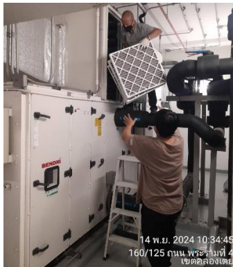
รูปที่ 3-41 การทำความสะอาดแผ่นกรองอากาศ
