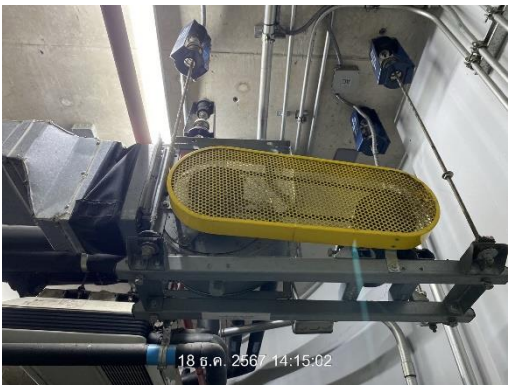
รูปที่ 3-14 พัดลมดูดอากาศในห้องพักมูลฝอยเปียก
